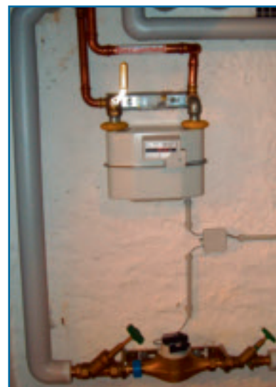
Fürs Smart Metering sind keine aufwändigen Installationen nötig. Vorhandene Technik kann genutzt werden, wie die Gas- und Wasserzähler auf dem Foto zeigen.
