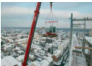
So sah es Anfang Dezember noch auf dem Dach des Hochhauses Frankfurter Straße aus. Trotz des strengen Winters gingen die Bauarbeiten zügig voran; fünf Stockwerke wurden bereits abgetragen. Mit der Errichtung des neuen Tonnendachs kann bereits im März begonnen werden. Offenbar
