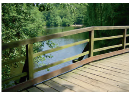
Unter dieser Holzbrücke erreicht der Erlenbach den Jakobiweiher.
