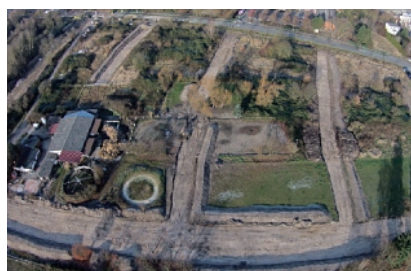
Beginn der Rodungsarbeiten am 24. Oktober 2016
