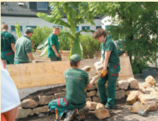
Die Lehrlinge bauen an der Natursteinmauer
