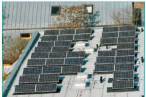
Quadratmetern entspricht. Insgesamt hat die Anlage eine Spitzenleistung von 6,65 Kilowatt Peak (kWp) und eine Oberfläche von gut 49 Quadratmetern. Insgesamt wurde eine Summe von 42.900 Euro investiert.
