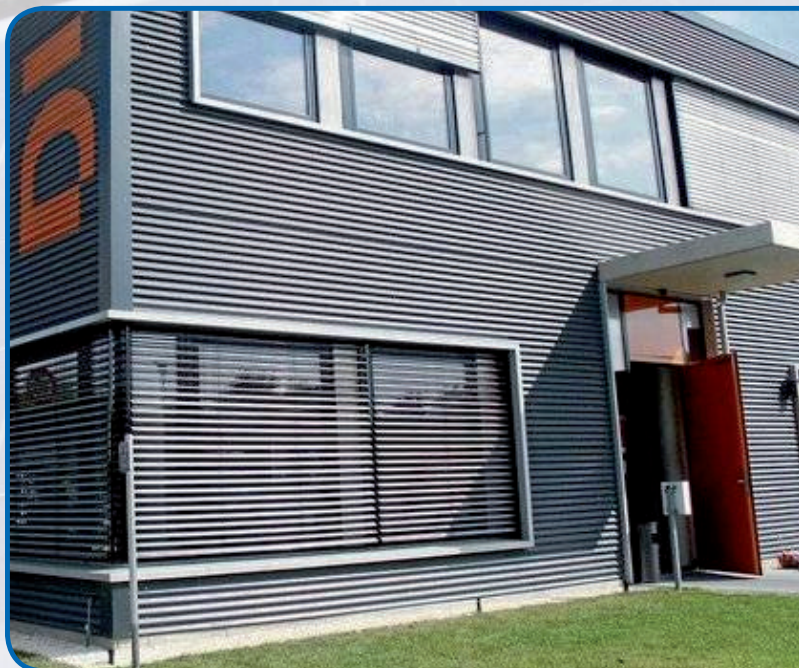
Die erste Neu-Isenburger Bürger-Solaranlage steht auf dem Dach des DLB-Gebäudes
