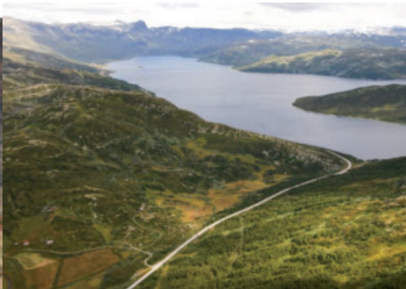
Das norwegische Wasserkraftwerk Sønnå H produziert 212 Megawatt
