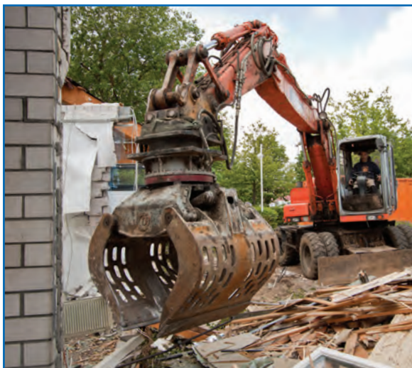
Der Abriss des alten Neu-Isenburger Hallenbads ist seit April in vollem Gange.
