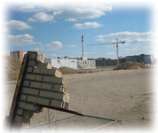
Vergangenheit und Zukunft – das neue Arrow-Areal –
