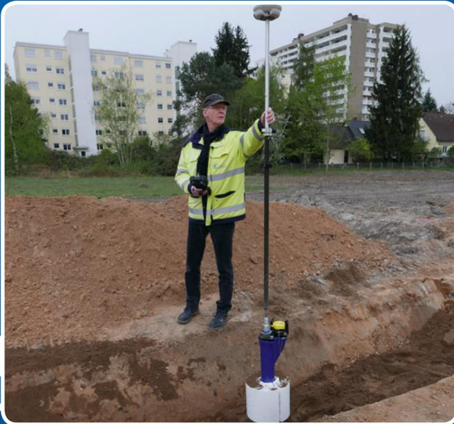
Er ist der Leiter der graphischen Datenverarbeitung Ihrer Stadtwerke Neu-Isenburg. Die neu verlegten Wasserleitungen werden unter Zuhilfenahme eines satellitengestützten Messgerätes erfasst, eingemessen und anschließend von ihm in ein graphisches Informationssystem eingepflegt.
