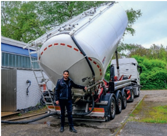
Christoph Pfaff überwacht die Sanierungsarbeiten und ist bei der Befüllung des Filterbehälters vor Ort.
