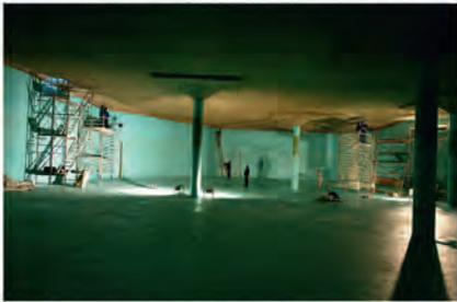
2007: Tiefbehälter– beide Wasserkammern wurden mit Edelstahlplatten ausgekleidet.
