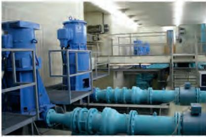
2005: Neue Pumpen, neue Leitungen – Umbau der Verrohrung mit modernen, energieeffizienten Pumpen.
