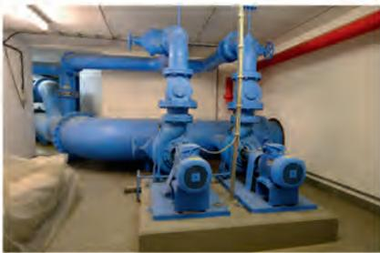
2022: Edelstahl statt Eisenrohre – Komplette Rohrerneuerung in der Wasseraufbereitung.
