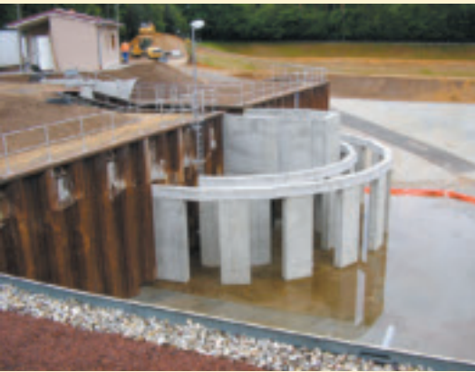
Einlaufbauwerk zum Absetzbecken
