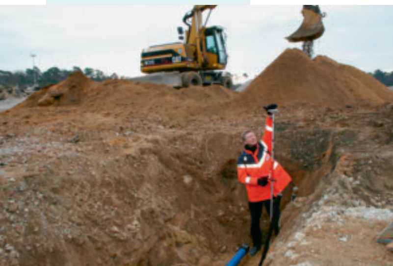
Auch in Gräben und Baugruben muss Stadtwerke-Mitarbeiter Gerhard Schirdewahn klettern, um mit Hilfe einer mobilen GPS-Einheit diverse Installationen zentimetergenau zu kartografieren.
