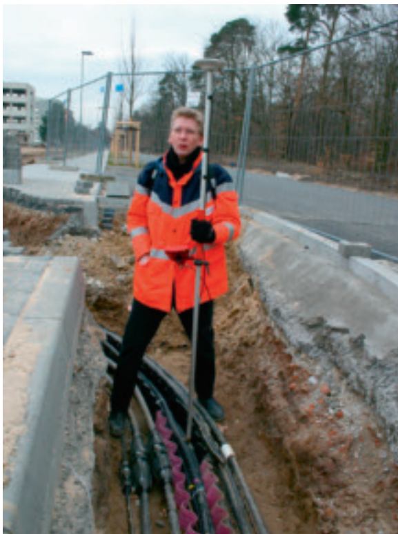
GPS-Mann Gerhard Schirdewahn vermisst und registriert, wo ein Kabel ein Verbindungsstück aufweist – eine so genannte Muffe. Wenn das Kabel unter Erde und Gehwegplatten verborgen ist, sind die genauen Koordinaten für eventuell später notwendige Reparaturen eine große Hilfe.
