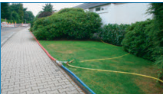
Hausanschlüsse überirdisch: Was sonst nicht zu sehen ist, wird hier offensichtlich. Die gelben Schläuche sind auch zur Wasserversorgung von Mehrfamilienhäusern ausreichend.
