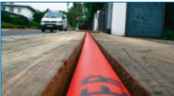
300 Meter Notwasserleitung müssen auch an Einfahrten vorbei verlegt werden. Die starken Balken schützen die Schläuche und machen das Überqueren einfach.
