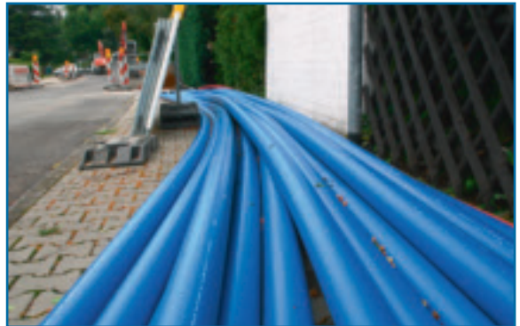
So sehen die modernen 100er Wasserleitungen aus Kunststoff aus. Bevor das Trinkwasser hindurchfließt, werden die Rohre gereinigt und desinfiziert.
