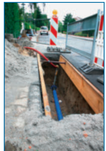
Gut zu sehen: Bis hierhin ist das blaue Wasserrohr aus Kunststoff verlegt. Die rote Notversorgungsleitung ist angeschlossen.
