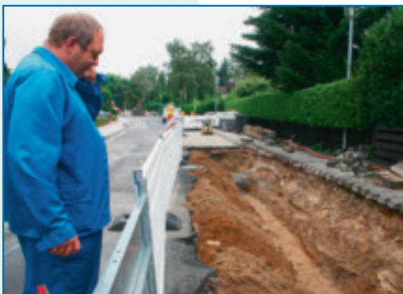
Der Graben ist ausgehoben, das neue Wasserrohr ist noch nicht drin. Rechts im Bild zu erkennen: Die Notversorgungsleitung.
