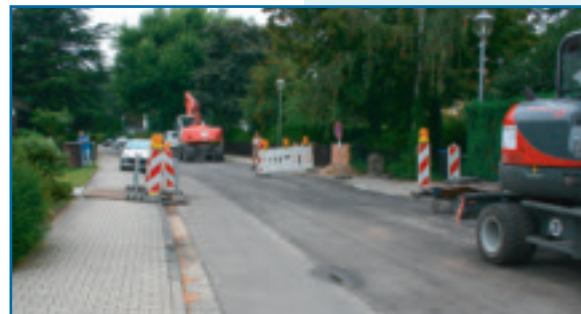
Rohre verlegt, Graben verfüllt, Asphaltdecke fertig: Für die Anwohner des Falkenwegs ist wieder alles wie zuvor.
