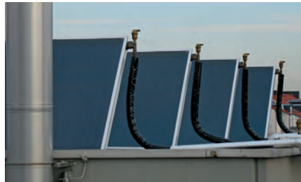
Solarthermie auf der Hugentottenhalle
