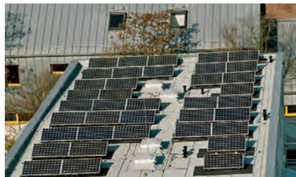
Photovoltaik auf dem Dach der Feuerwehr
