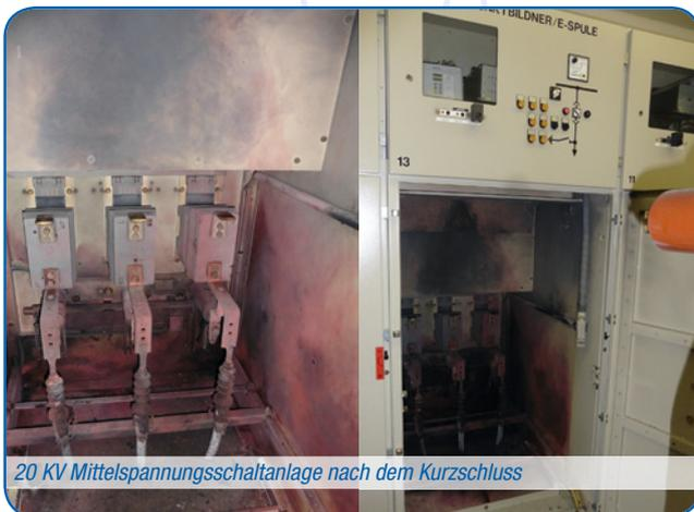
*20 KV Mittelspannungsschaltanlage nach dem Kurzschluss*
