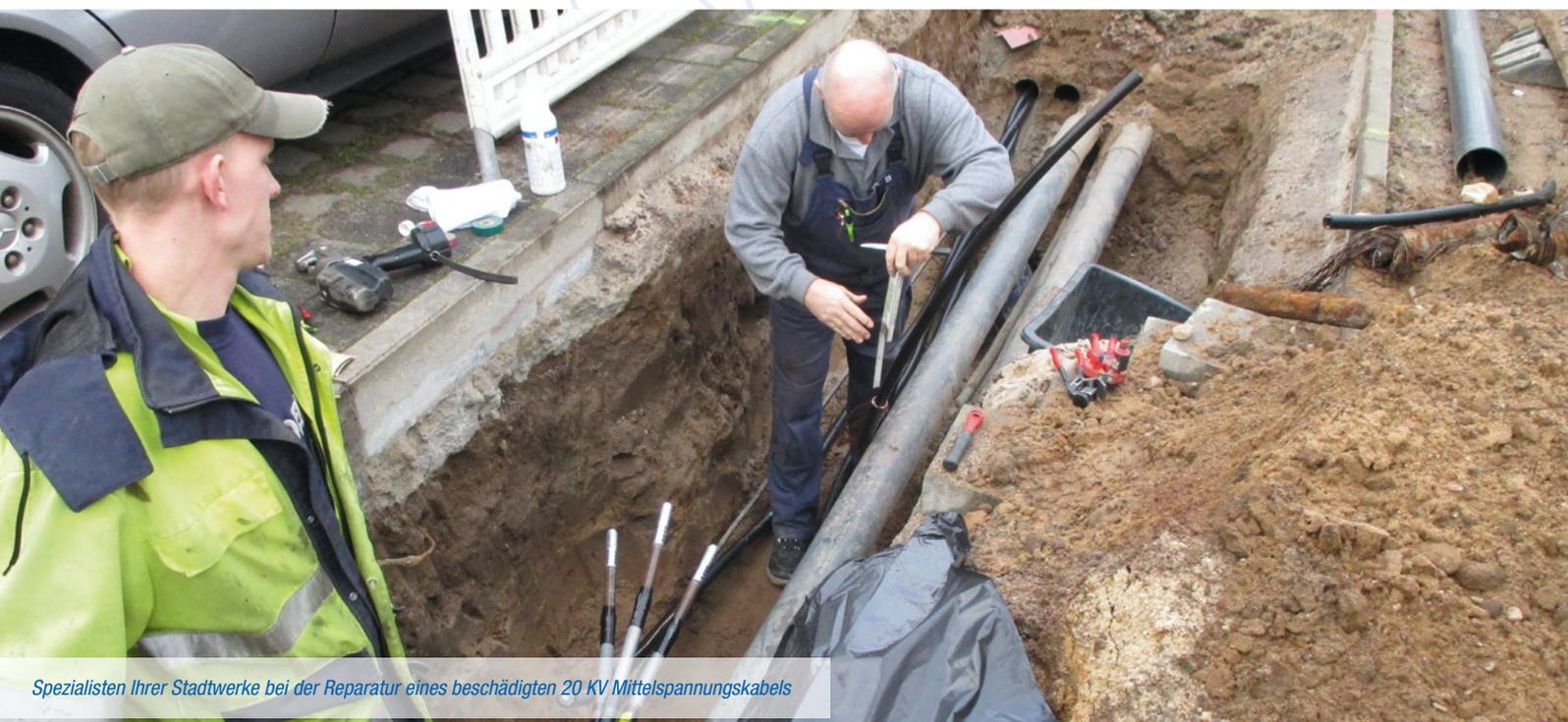
*Spezialisten Ihrer Stadtwerke bei der Reparatur eines beschädigten 20 KV Mittelspannungskabels*
