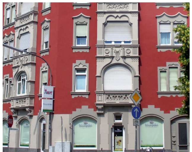
Frankfurter Straße Nr. 20 an der Ecke zur Löwengasse.
