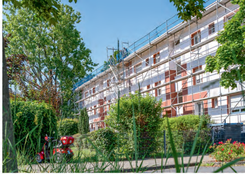
Im Areal rund um die Gartenstraße wurden im Sommer 15 Häuser mit Solarmodulen ausgestattet.
