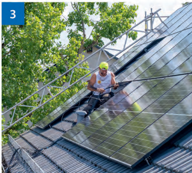
3 Die Module werden miteinander verschaltet.
