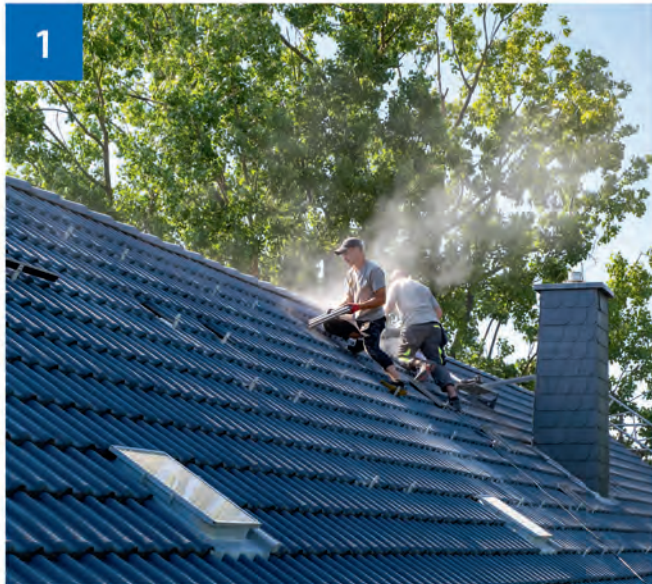
1 Auf dem Dach werden Dachhaken angebracht, welche die Montageschienen, auf die später die Solarmodule geklemmt werden, mit der Dachhaut verbinden.
