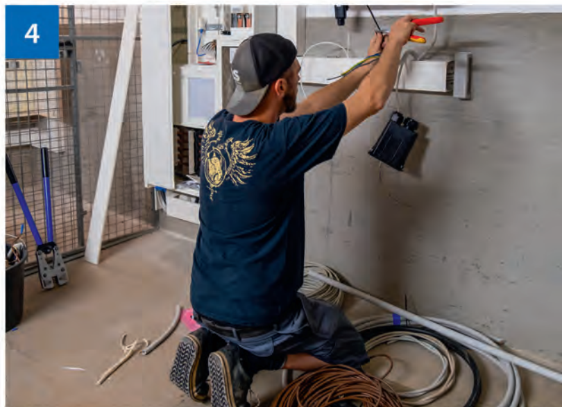
4 Die Solarmodule werden an das Hausnetz angeschlossen.
