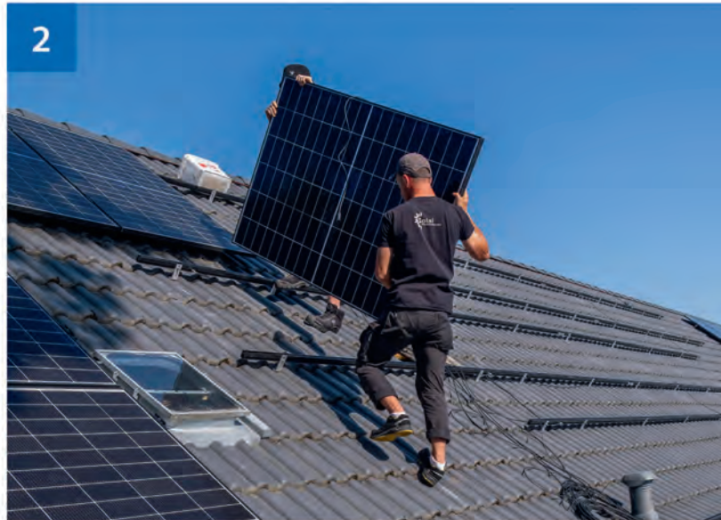
2 Nach dem Anbringen der Montageschienen werden die Module sicher auf dem Dach fixiert.
