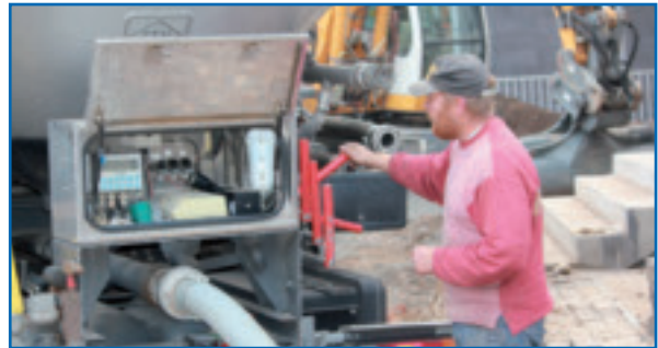
Befüllung des Pelletslagers mit einer halben Tonne pro Minute
