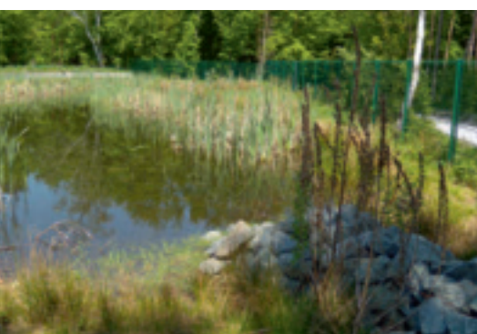
Sickeranlage Frankfurter Stadtwald: Neu angelegtes Laichgewässer
