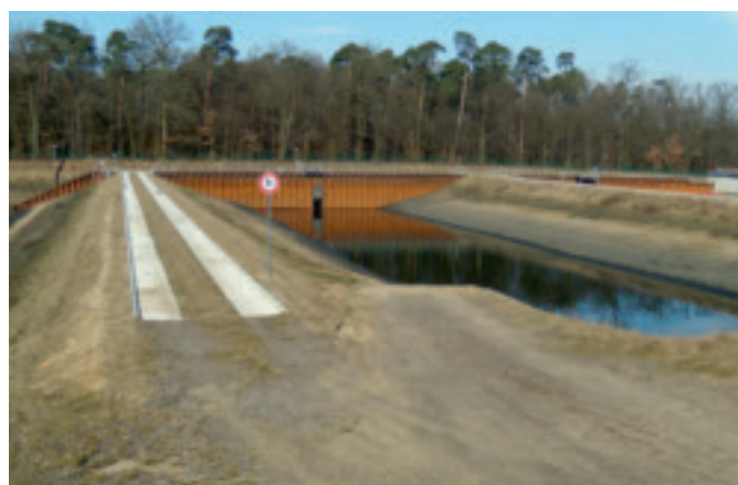
Sickeranlage im Frankfurter Stadtwald, kurz nach dem Umbau
