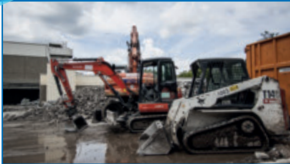
Mit großem Gerät täglich im Einsatz - damit unser neues Hallenbad pünktlich fertig wird.
