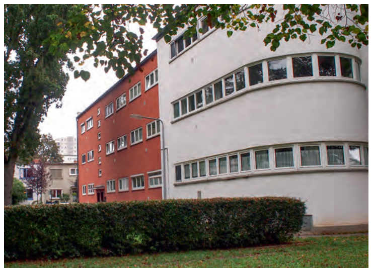
Mehrfamilienhaus in der Römerstadt. Im Hintergrund links das mayhaus, Fotos: Ulrich Fogel
