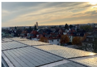
Die Bürger-Solaranlage auf dem Rathausdach (Inbetriebnahme 2011)
