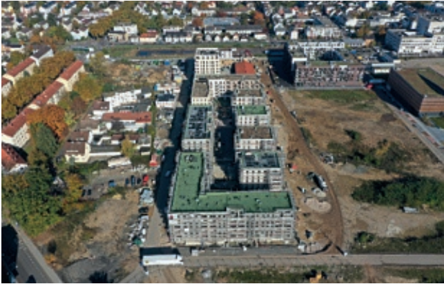
Stand der Bauarbeiten Ende Oktober 2024
